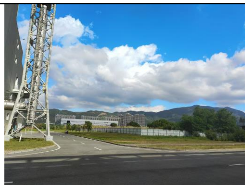
厂区西北侧福英泰
